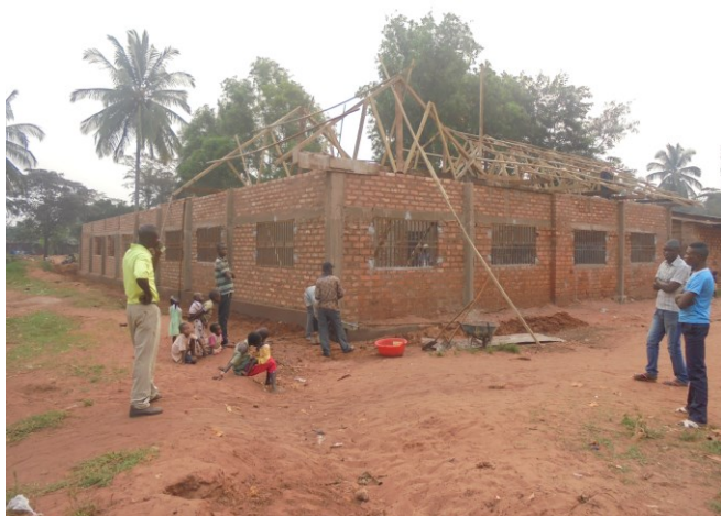
Première phase de construction de l'école de Kele-Mabondo
