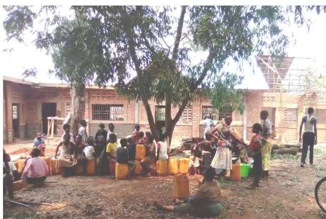
Prise d'eau à la cour d'école de Kele-Mabondo. Dans la partie arrière du bâtiment en construction
