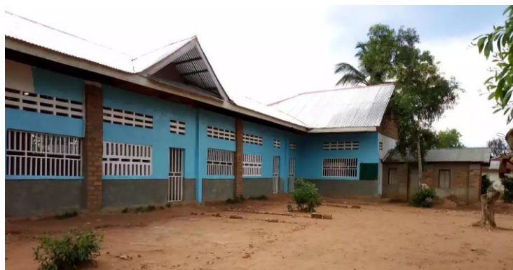
Son état après la reconstruction : première partie : 2018
